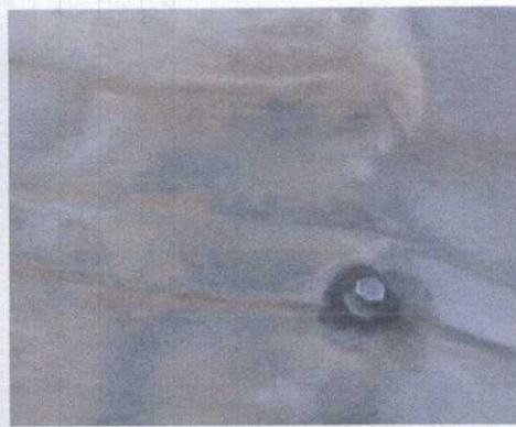
Desgaste do parafuso
