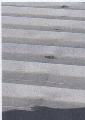
Desgaste do parafuso
