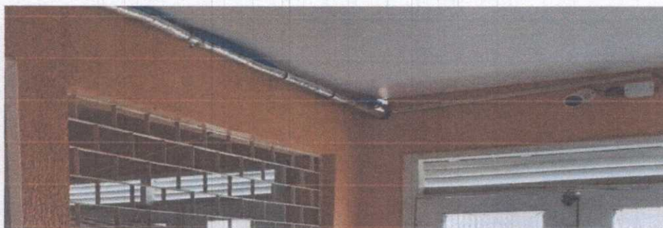
Tubo de sucção e fiação externa
