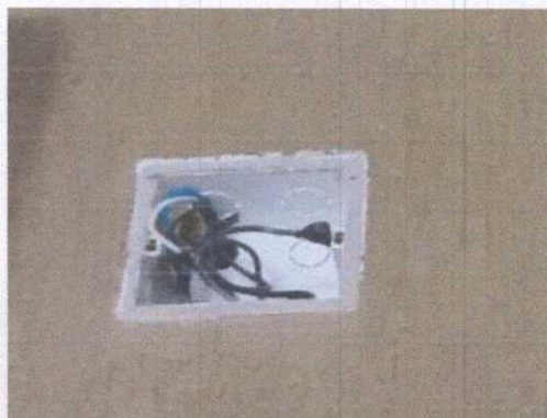
Caixa de passagem sem proteção
